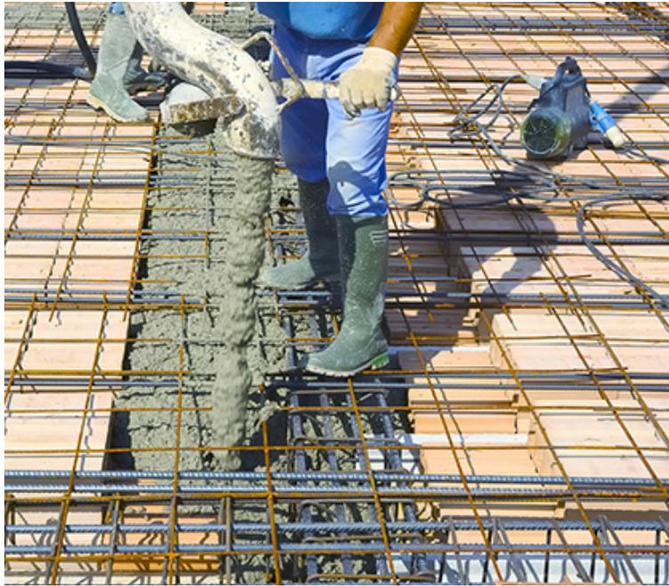
この高層の商業ビルを建設するには、すべてのコンクリートを地上259メートル上の80階までポンプで運ぶ必要があるため、最高の高性能AE減水剤が必要でした。また、コンクリートは、鉄筋の相互作用のために異なる床面高さに対して160mm~200mmのスランプ範囲を満たさなければなりません。
