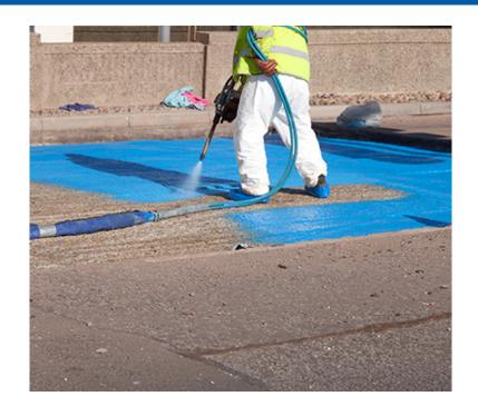
この輸送インフラの設計には、排水特性と保水特性を備えた止水システムを提供するシステムが必要でした。 水を運河の中に保持しながら、水がコンクリートのトンネルに浸透しないことを保証しました。
