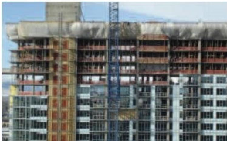
高層ビルには、約8,000立方ヤードのSCCと新しい最新鋭の混合技術ADVA<sup>®</sup>408を使用して作成された厚さ3フィートの壁を備えた2つの巨大なコンクリートコアが含まれています。
