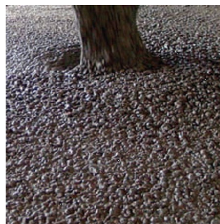
スーパー20F 使用による 流動化コンクリート
